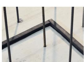
3. Coloque la cinta expansiva de bentonita MASTERSTOP en el centro de la junta. La cobertura de hormigón posterior debe ser de al menos 8 cm en todos los lados.
