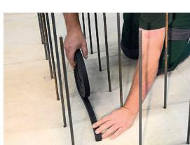
2. Coloque la cinta expansiva de bentonita MASTERSTOP sobre la superficie uniformemente.
