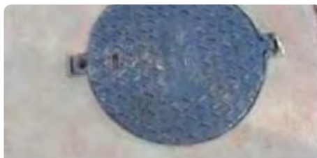
2 · Tapa instalada a nivel
