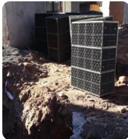
Condominio Av. Central Constructora Blanca Estrella
