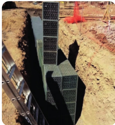
Edificio El Rodeo, Santolaya Constructora Santolaya Ltda.
